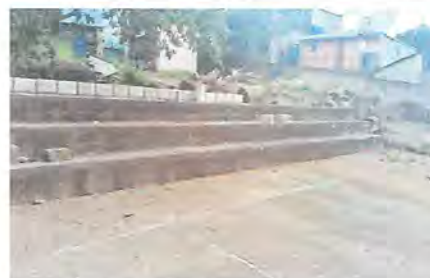
Foto 6: pegado de block, dos hileras para proteccin de la cancha, para que no se llene de agua.
