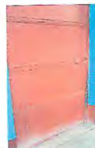
Foto 6: Sustitución de una puerta.
