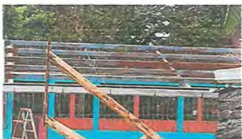
Foto 3: Sustrucción de lamina por lamina croquelada, de dos aulas.
