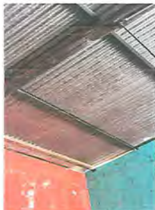
Foto1: Sustrucción de lamina por lamina croquelada, en el area de la direccin y pintado de la estructura metálica.
