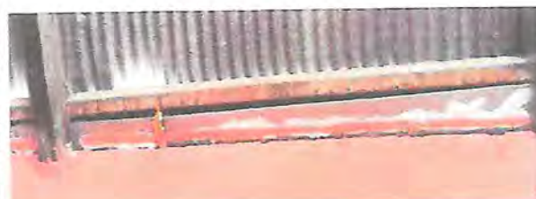
Foto 2: Sustitución de canal interno de metal, se filtra el agua.
