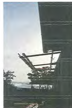
Foto2: Colocacin de lámina croquelada, en el frente de la direccin.
