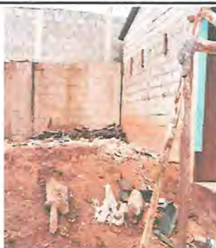
Foto 5: Construcción de cocina para la alimentacin escolar.
